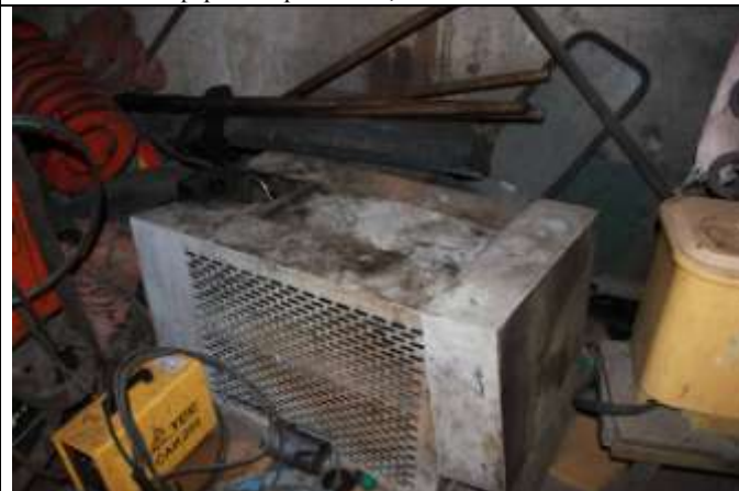
Фото 21 Отопитель на отработанном масле фирмы «Кролл» W401K
