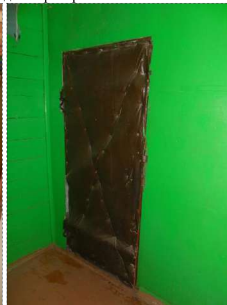
Фото № 16. Дверь в основное строение.
