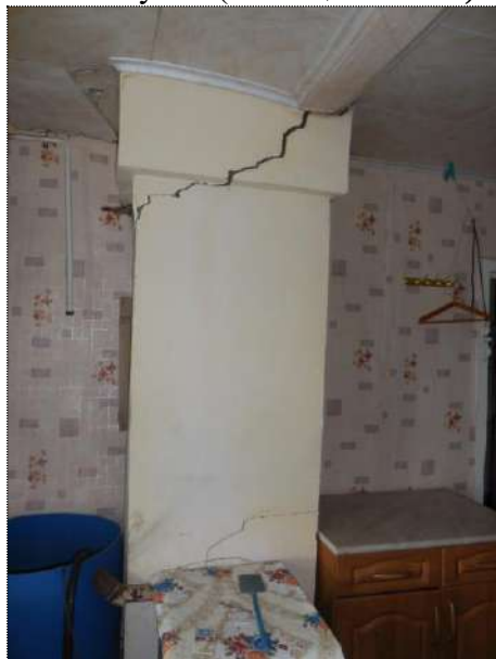
Фото № 19. Кухня (помещение № 1).
