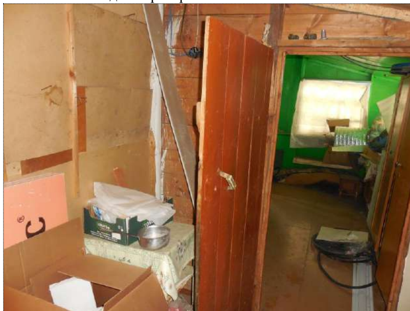
Фото № 15. Холодная пристройка.
