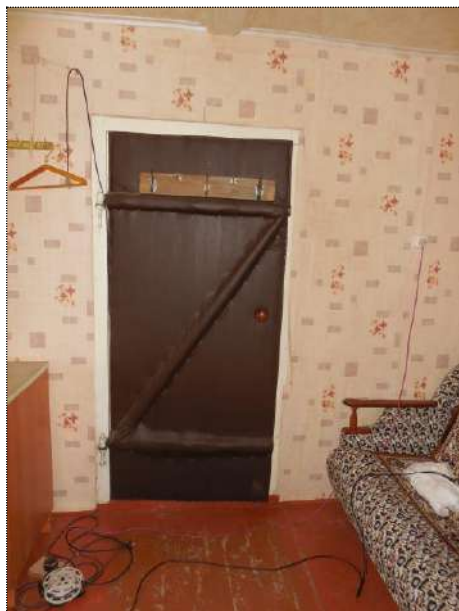
Фото № 21. Дверь в жилую комнату (помещение № 2).
