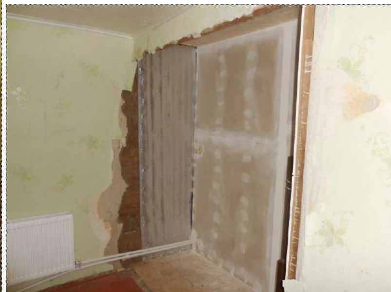
Фото № 24. Жилая комната (помещение № 2).
