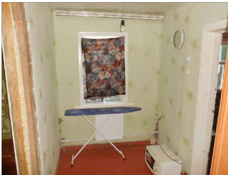
Фото № 22. Жилая комната (помещение № 2).
