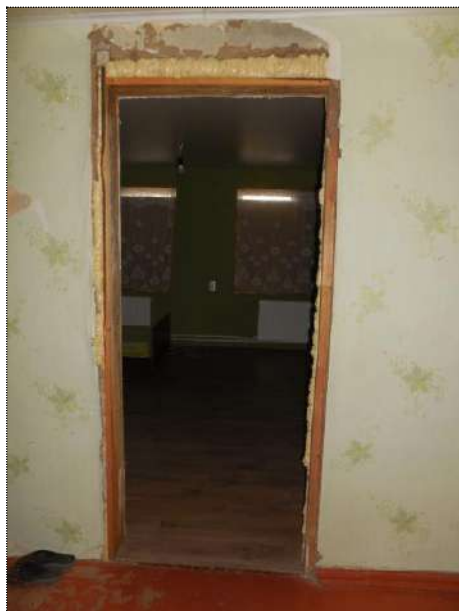
Фото № 25. Дверь в жилую комнату (помещение № 3).
