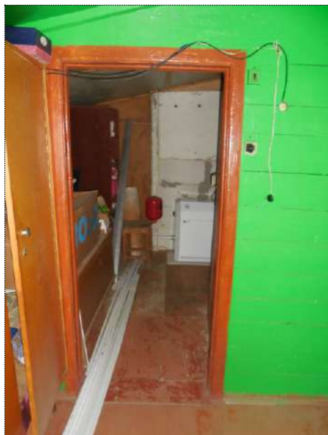
Фото № 13. Холодная пристройка.
