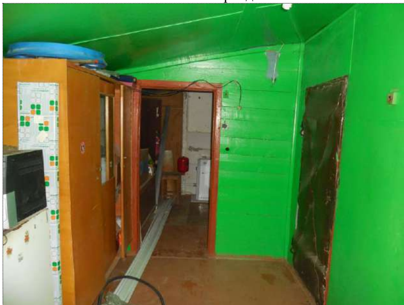
Фото № 11. Холодна пристройка.
